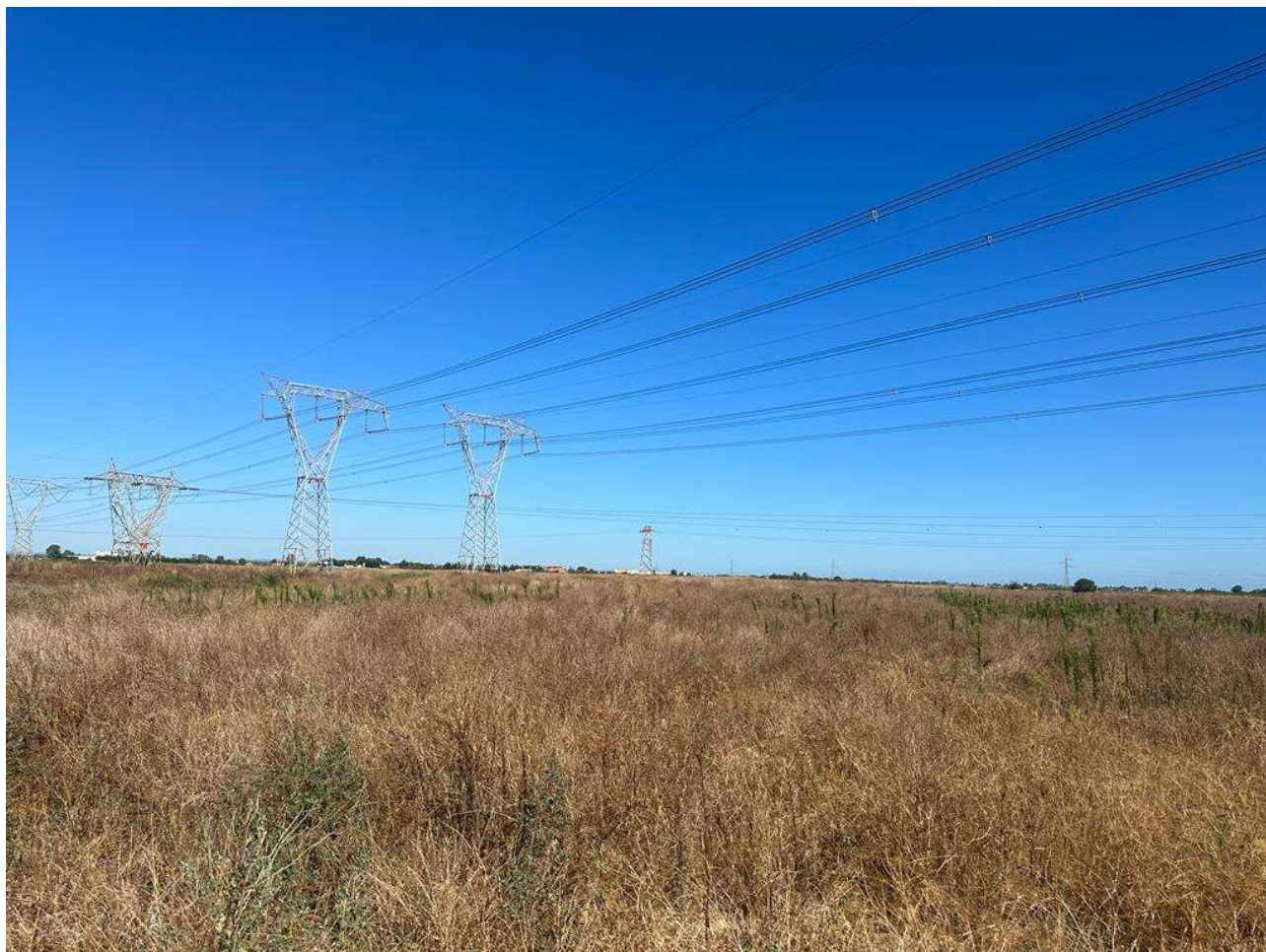
Rilievo delle attuali funi di guardia prive di sfere di segnalazione volo a bassa quota
